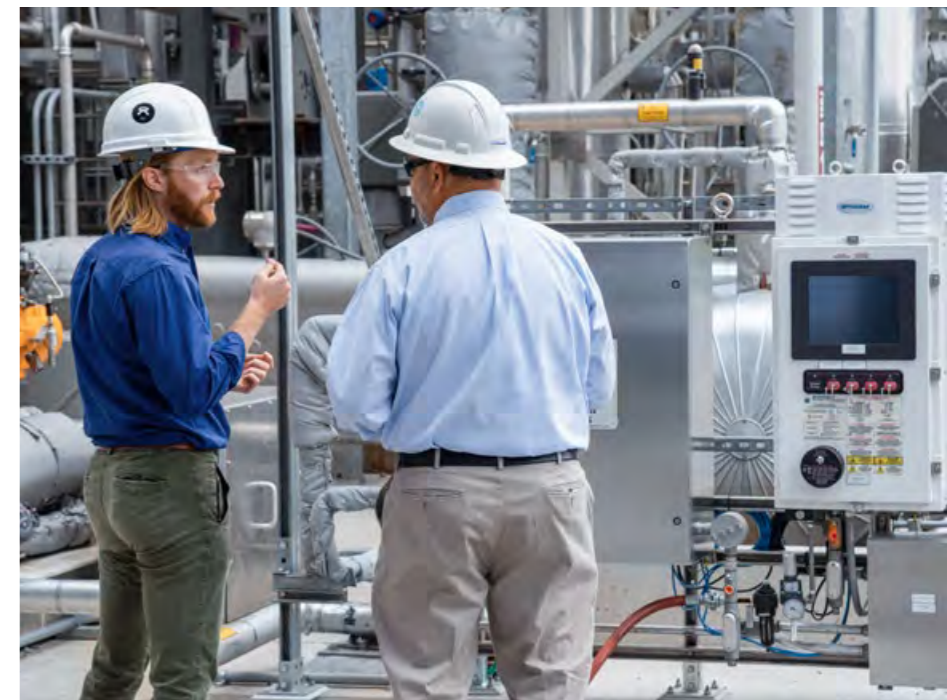
拉曼分析仪(右侧机柜)可以精确监测和控制注氢过程。
