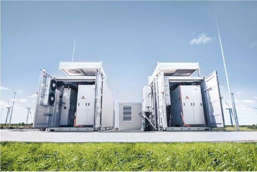
Les électrolyseurs de l'entreprise H-Tec Systems sont compacts. Dans des conteneurs mobiles, des stacks PEM produisent de l'hydrogène avec efficacité.
