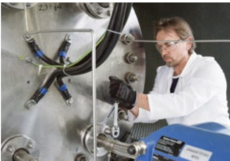
可靠、精确和坚固：巴登-符腾堡州太阳能和氢能研究中心依靠Endress+Hauser仪器监测电解过程。
